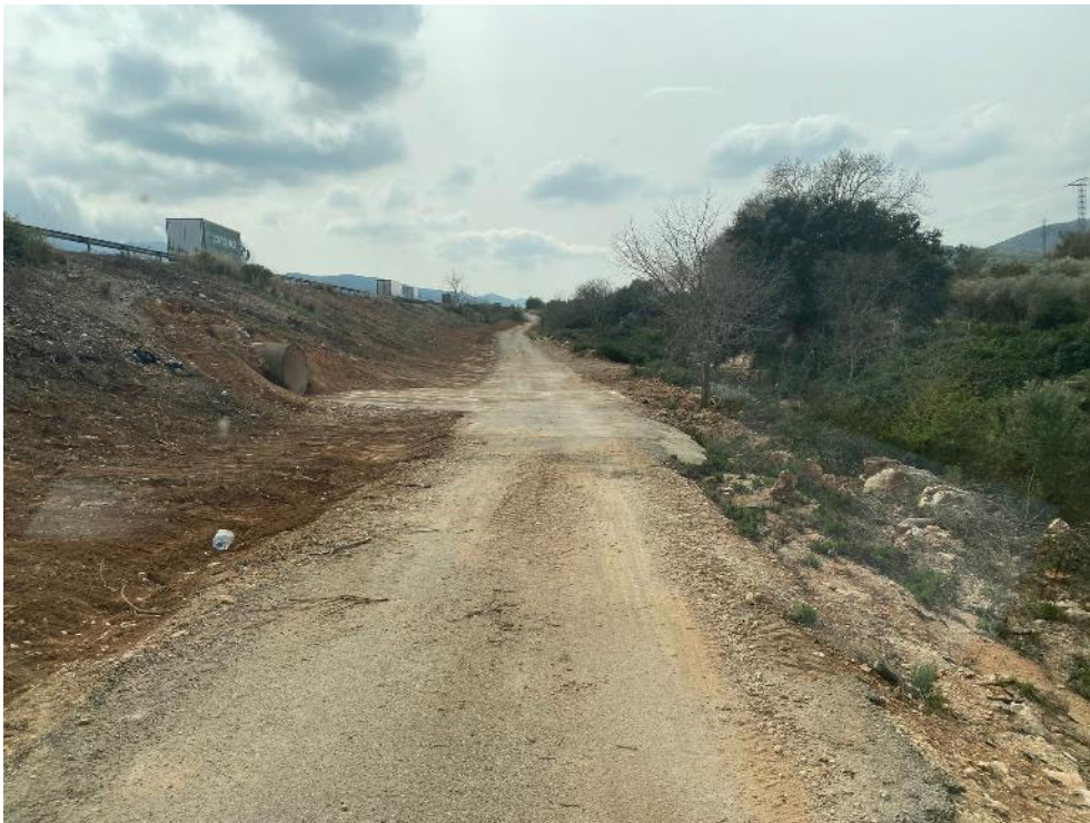
Limpieza de tierras y lodos
