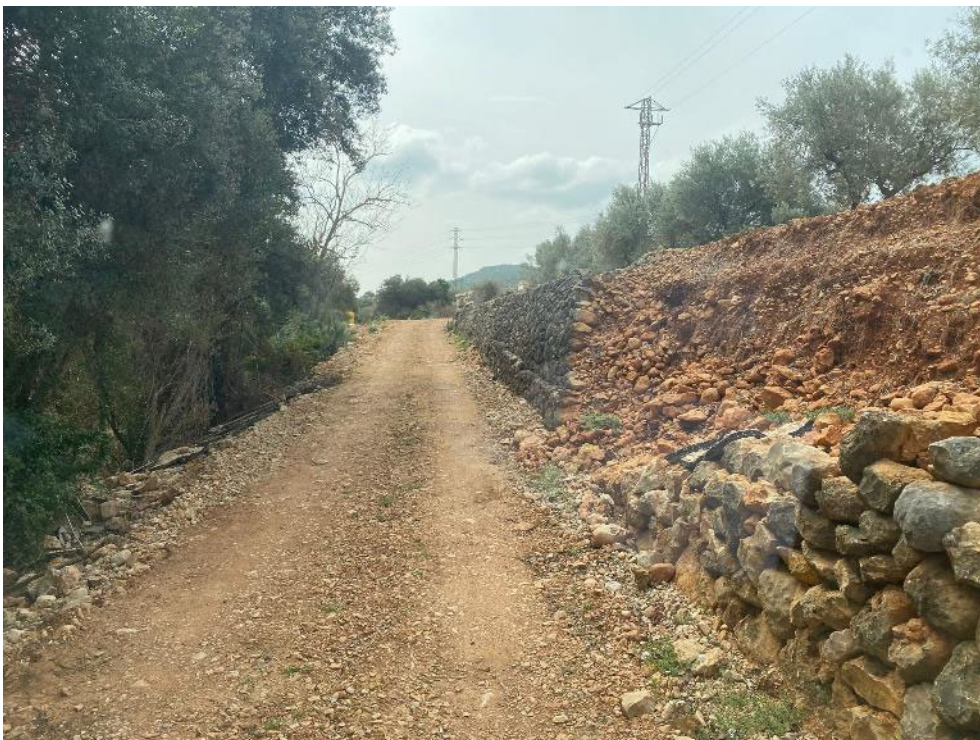
Limpieza de tierras y relleno
