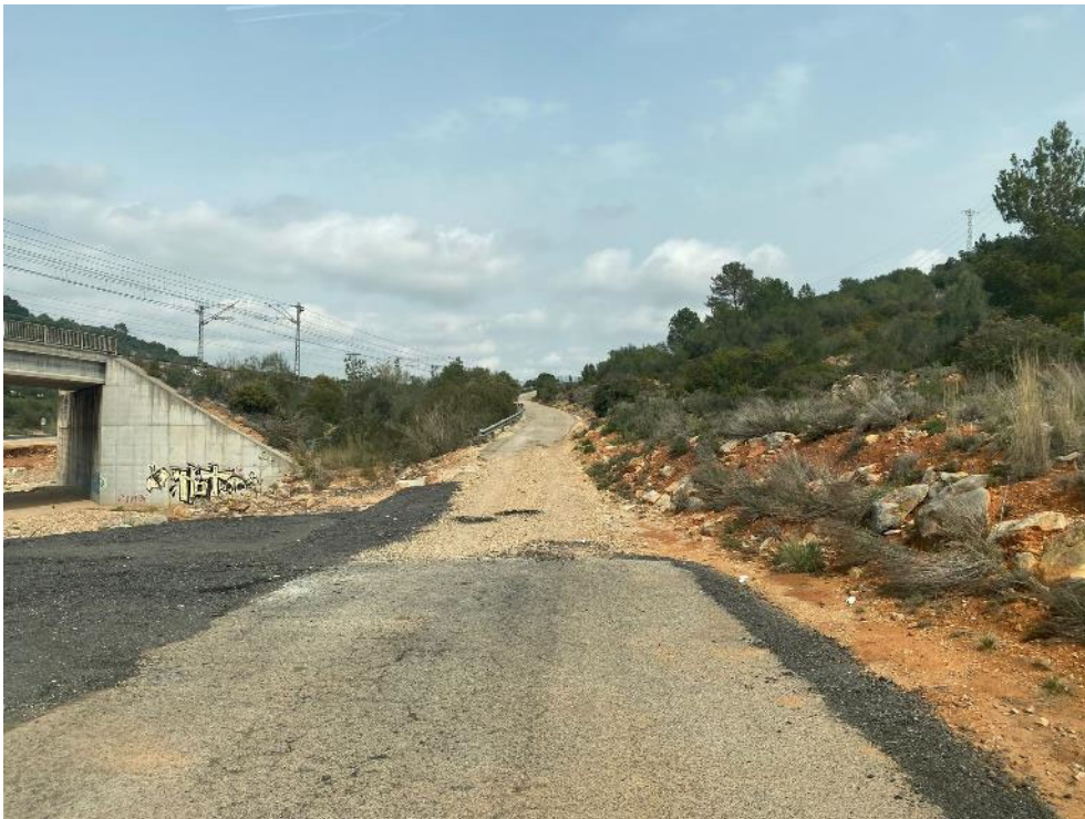
Limpieza de tierras y relleno
