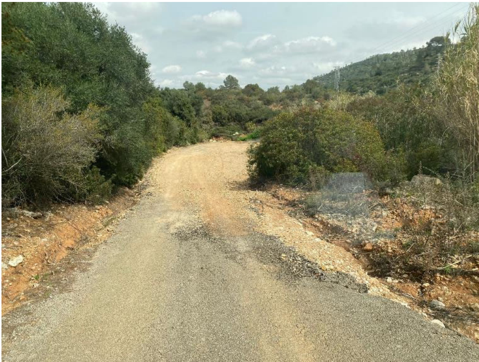
Limpieza de tierras y relleno
