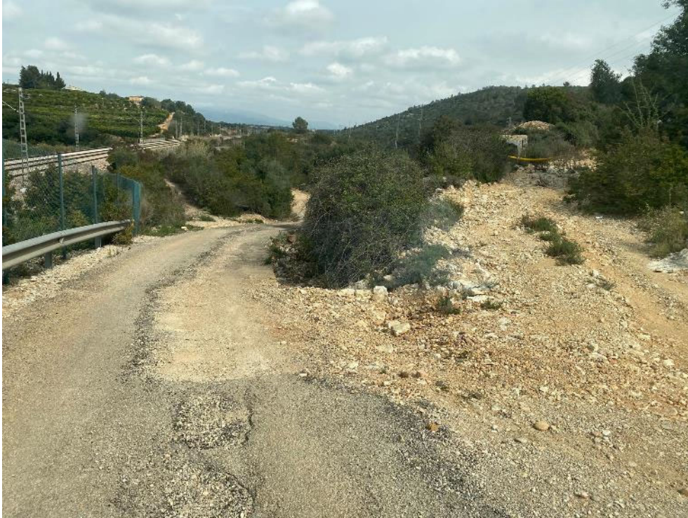
Limpieza de tierras y relleno
