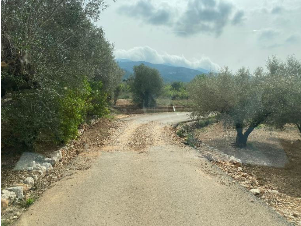
Limpieza de tierras y relleno
