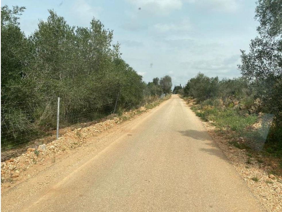
Limpieza de tierras y lodos
