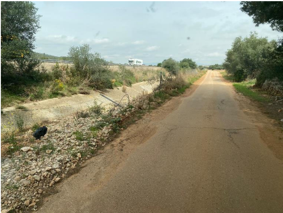
Limpieza de tierras y lodos
