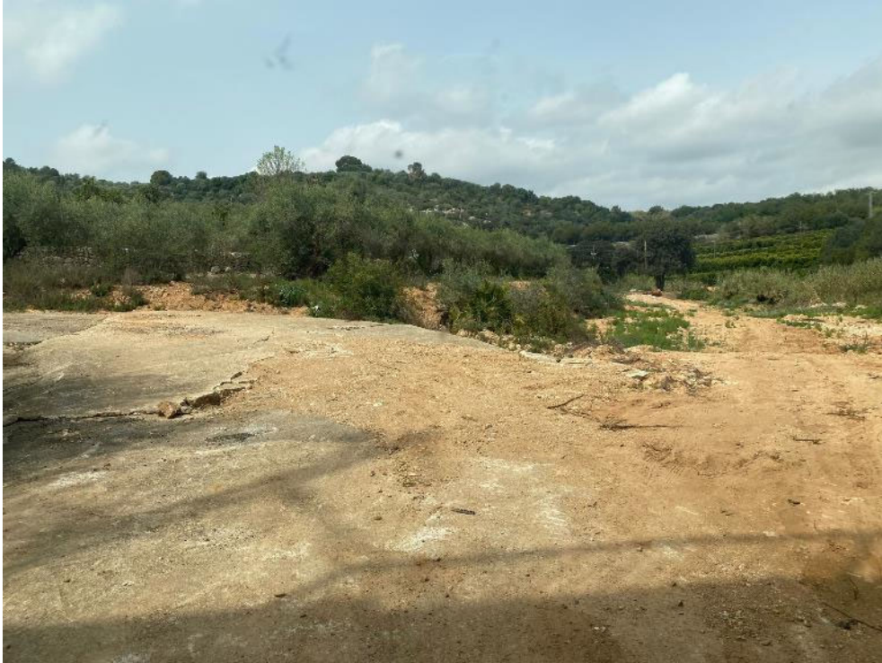
Limpieza de tierras y relleno
