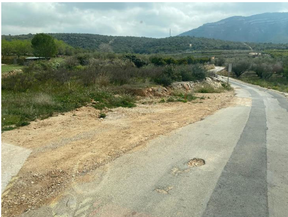
Limpieza de tierras y lodos
