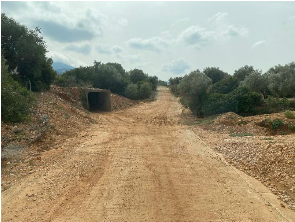
Limpieza de tierras y lodos
