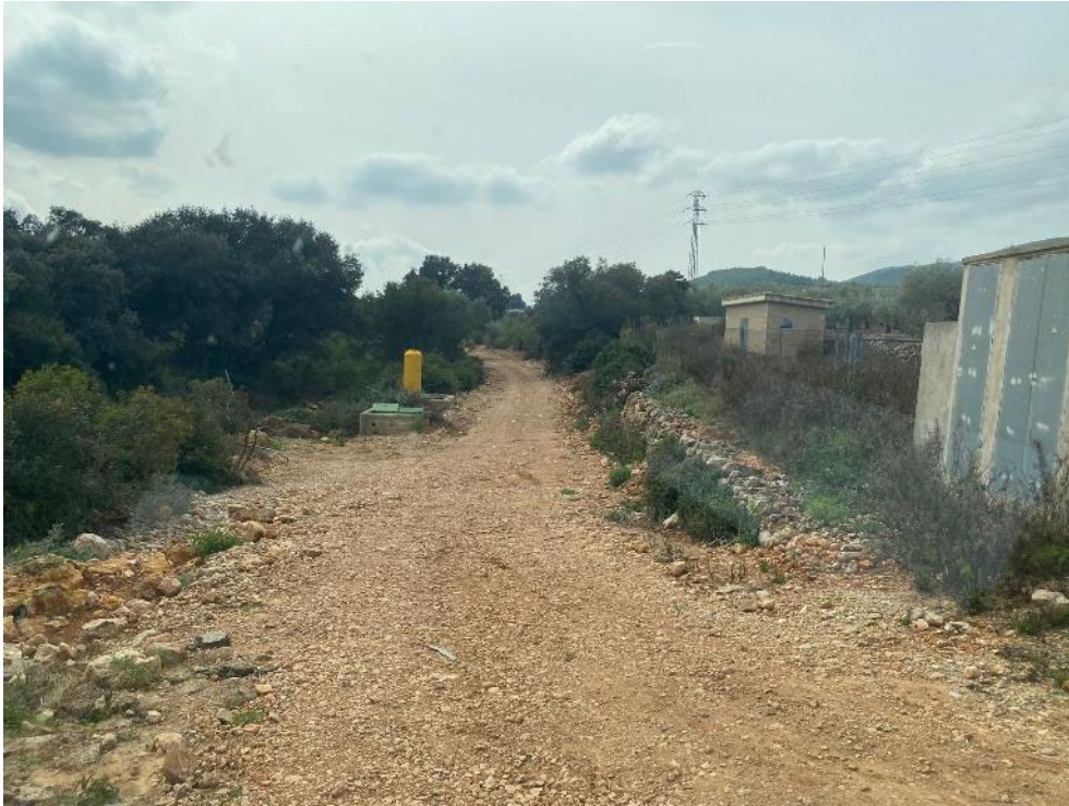
Limpieza de tierras y relleno
