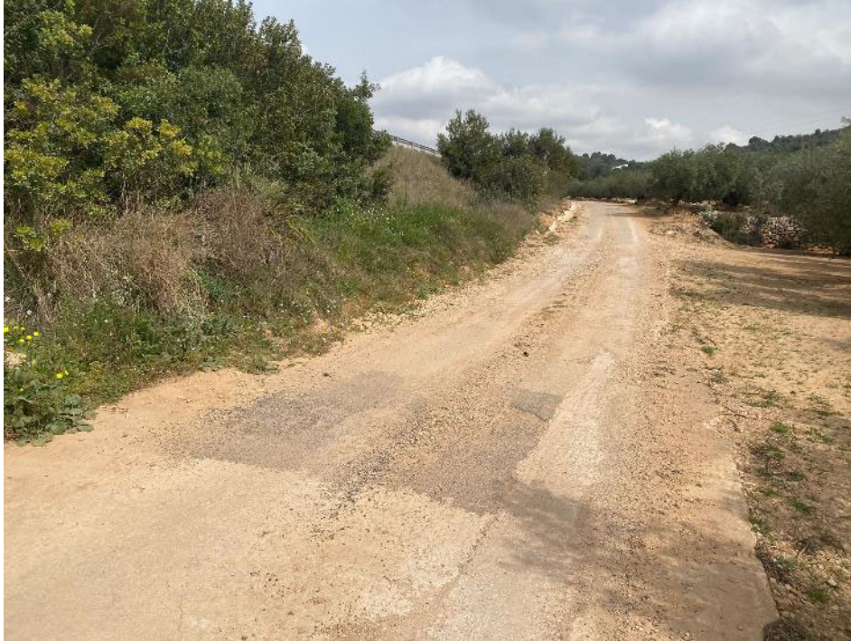
Limpieza de tierras y lodos
