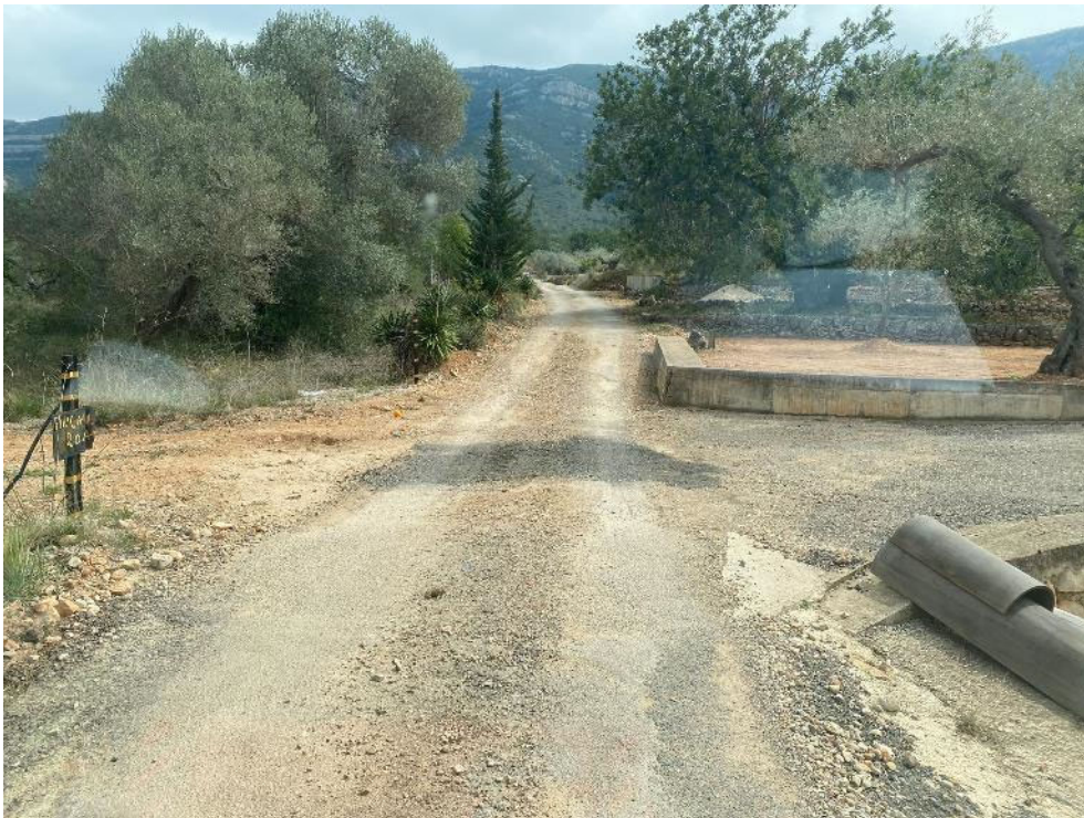
Limpieza de tierras y relleno
