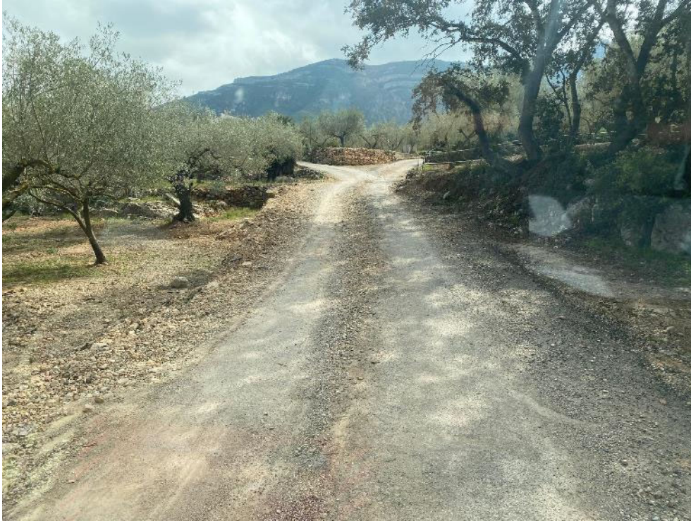
Limpieza de tierras y relleno
