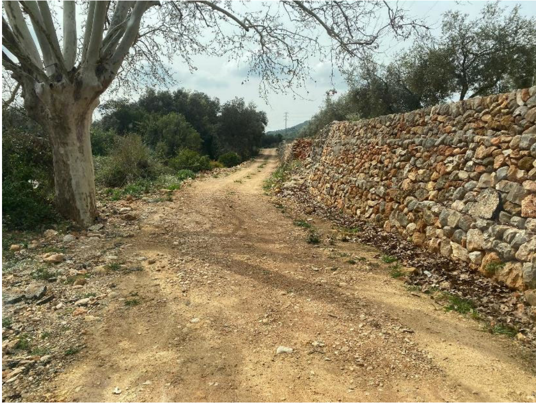
Limpieza de tierras y relleno
