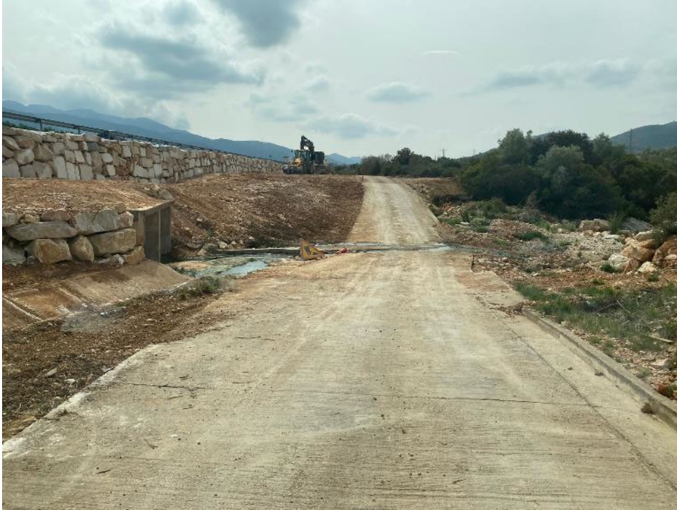
Limpieza de tierras y lodos
