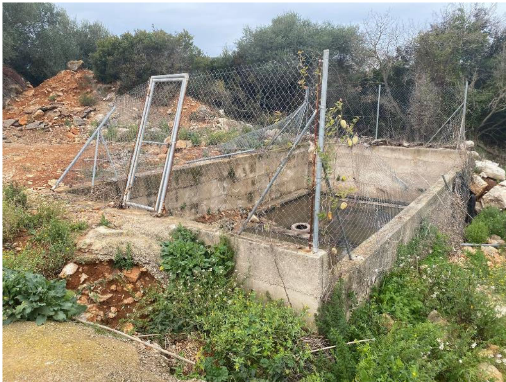
Vista de l'estat actual del dipòsit d'aigües residuals (07/03/2024)
