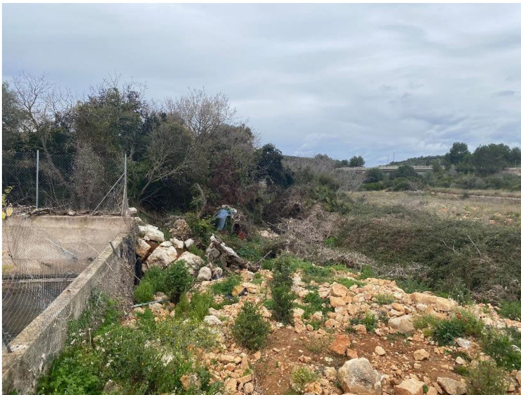
Vista de l'estat actual del barranc on el dipòsit d'aigües residuals aboca les aigües decantades (07/03/2024)
