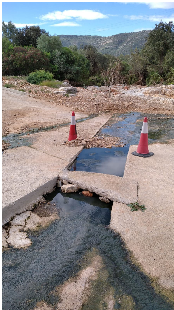
Vista de la rasa existent per al pas de les aigües decantades cap al barranc
