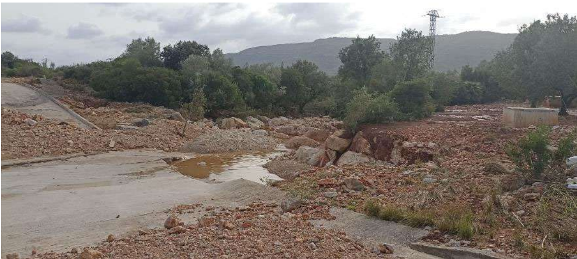
Vista de la via de servei després de la DANA
